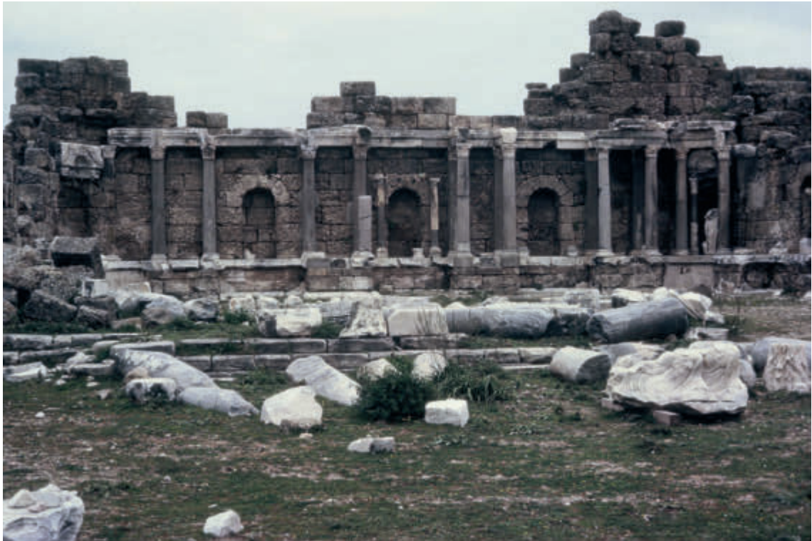
1 Side, »Gebäude M« nach den Restaurierungsarbeiten Ende der 1960er Jahre
