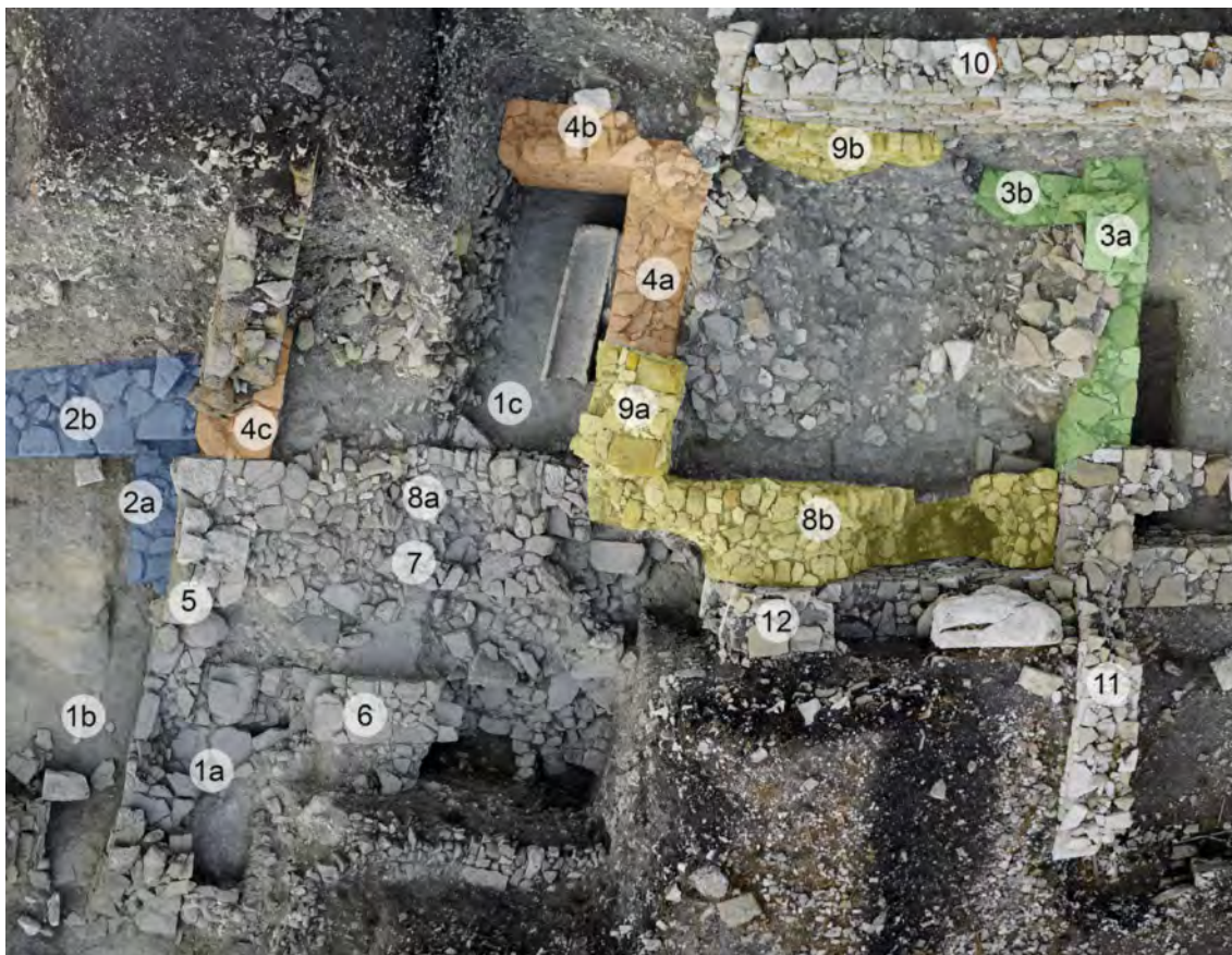
16 Bereich I, Westen: 1a: archaischer Ost-West-Kanal, 1b: Entwässerungskanal des Korridor des spätarchaischen Hauses; 1c: archaisches Außenniveau östlich des spätarchaischen Hauses; 2a: Ostmauer des spätarchaischen Hauses, 2b: Korridor Nordmauer des spätarchaischen Hauses; 3a: Ostmauer des Baus I, 3b: Binnenmauer des Baus I, 4a–c: Annexbau H, 5: frühhellenistische Nord-Süd-Mauer, 6: frühhellenistische Ost-West-Mauer, 7, 8: frühhellenistische Ost-West-Mauern, 9a–b, 8b: Mauern des frühhellenistischen Einraumhauses, 10: lange Ost-West-Mauer, 11: Westmauer eines mittelhellenistischen Breitraumhauses, 12: römische Ost-West-Mauer
