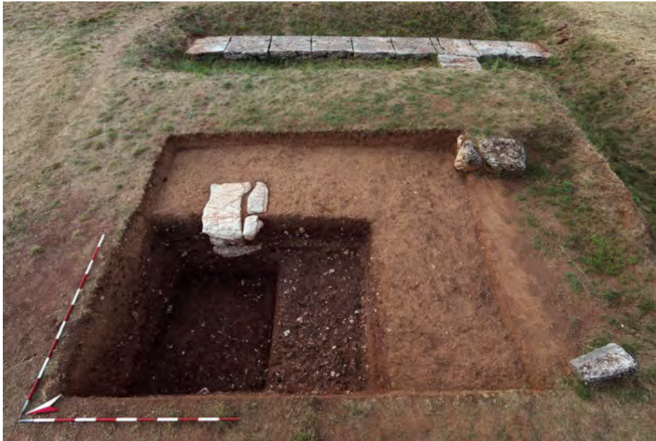
19 Fundament der südlichsten Innenstütze in Schnitt LSH 17/1 von Westen
