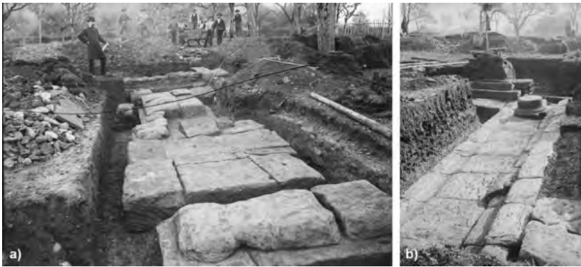
2 Fotografische Dokumentation der Grabungen 1887; a) im Bereich der Grabungsfläche 2016/17; b) unmittelbar nordwestlich anschließend mit Blick auf den Treppenabgang zur Area
