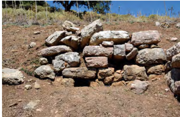
4 Leontion. Westlich an Turm 4 anschließender Kurtinenabschnitt am Südhang mit Wasserdurchlass
