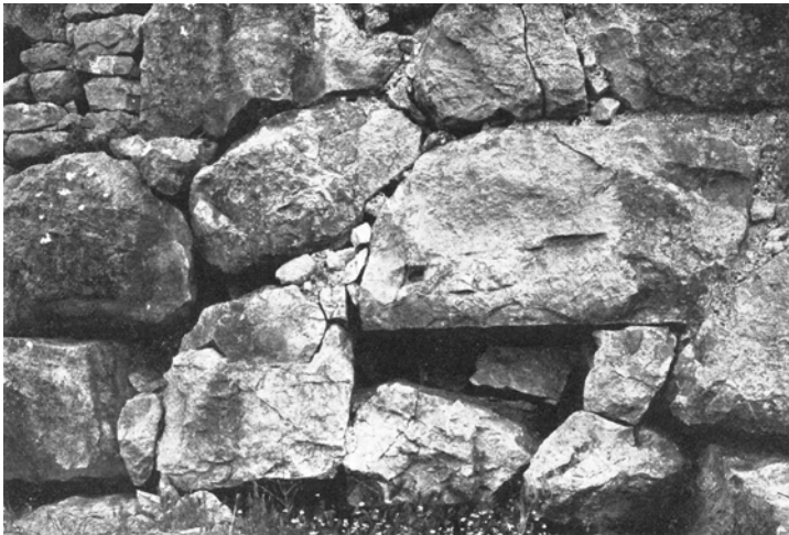
186 Akrokorinthos, ›kyklopisches‹ Mauerwerk (aus Carpenter 1936a, Abb. 26)
