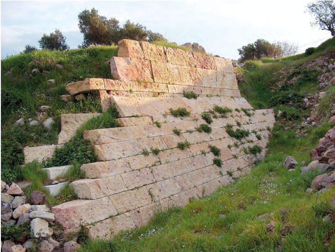
65 Phokaia, Kurtinenabschnitt der archaischen Befestigungsmauer mit geböschtem Sockel (Foto O. Hüllden)
