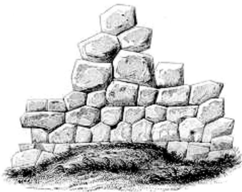
7 Polygonales Mauerwerk des Befestigungsringes von Melos (aus Blouet 1831–1838, Taf. 26, 2)
