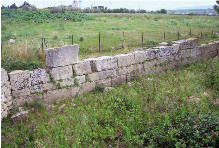
125 Megara Hyblaia, Befestigungsmauer mit leichter Böschung (Foto O. Hülten)
