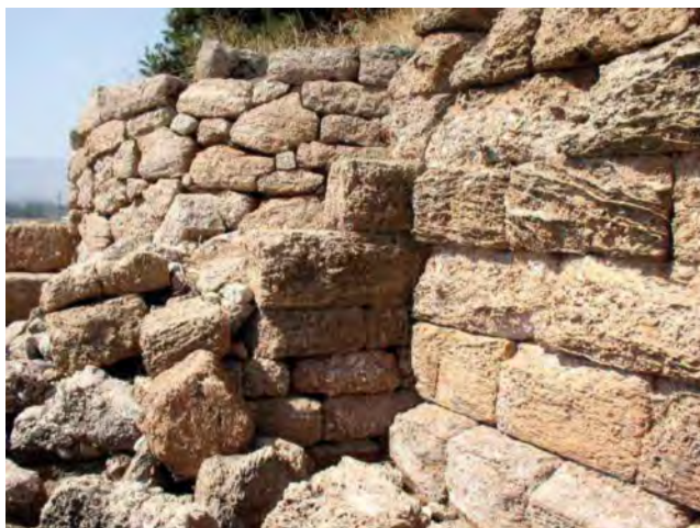
193 Larymna, von Quadermauer ummantelte Bastion (aus Nankov 2009, Abb. 8.83)
