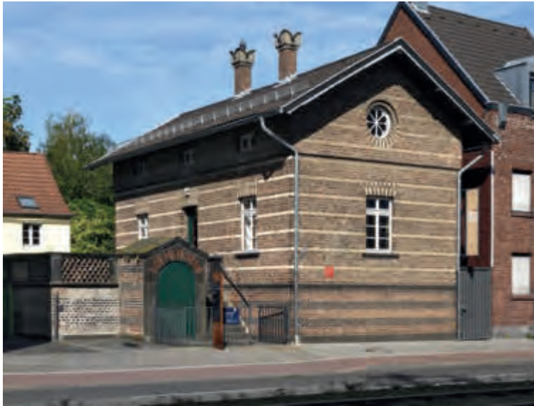
2 Außenansicht von Schutzbau und Chaussee-Aufseher-Häuschen, 2019 (Förderverein Römergrab Weiden e. V., Foto A. Thünker DGPh, Bonn)
