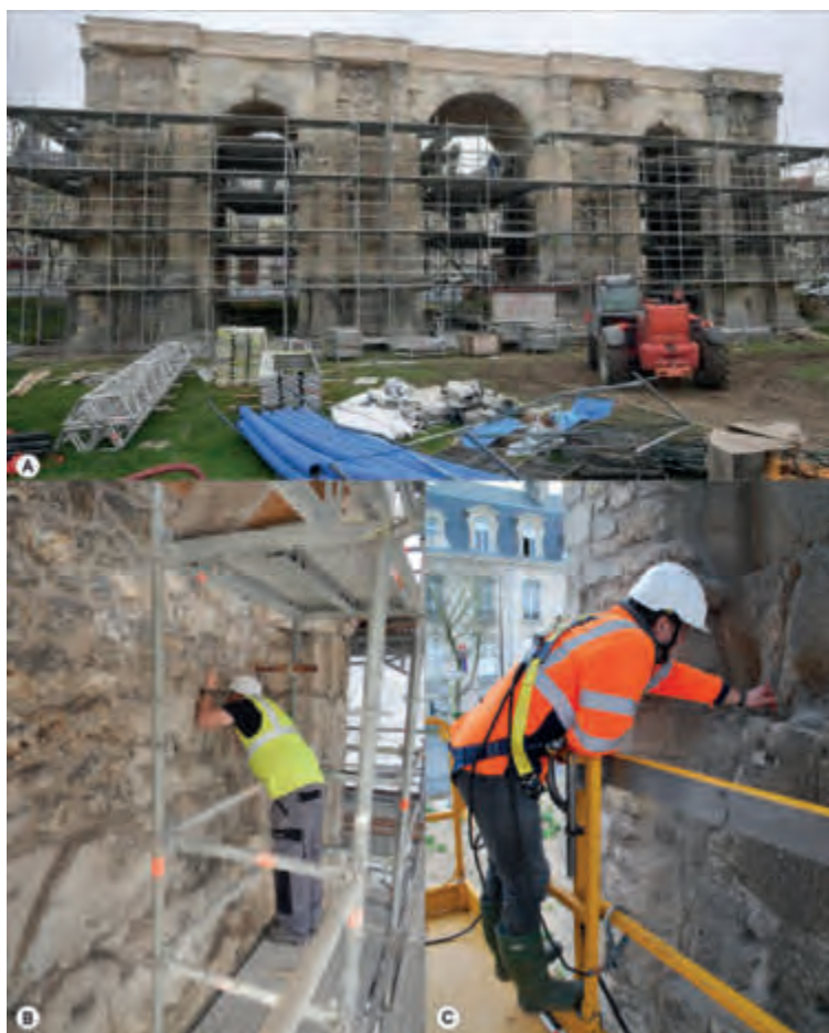
2 a) Échafaudages autour de l'arc, b) description géologique des blocs, c) relevés architecturaux (S. Laratte et V. Brunet-Gaston)
